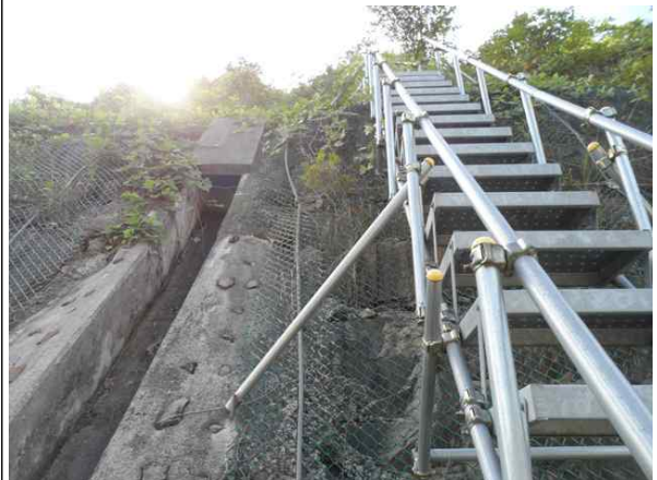
수직도수로, 점검계단 전경
