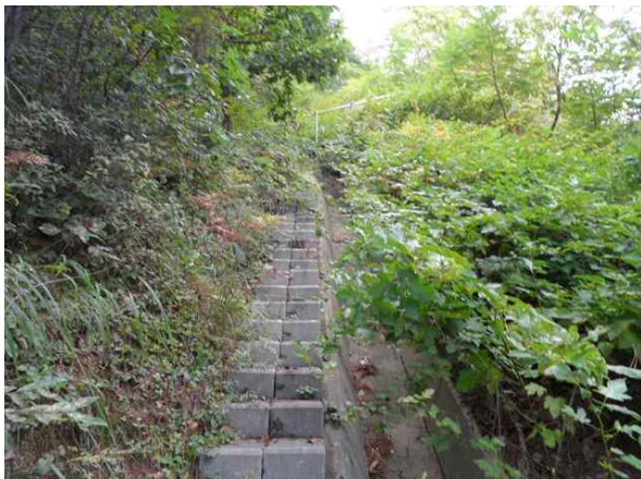
산마루측구, 점점계단 전경
