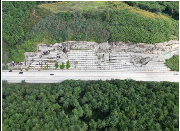
사면내 옹벽 전경
