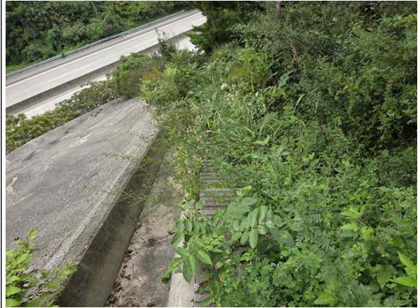
점검계단, 산마루측구 전경
