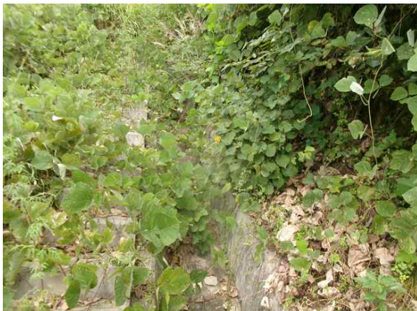
산마루측구, 점검계단 전경
