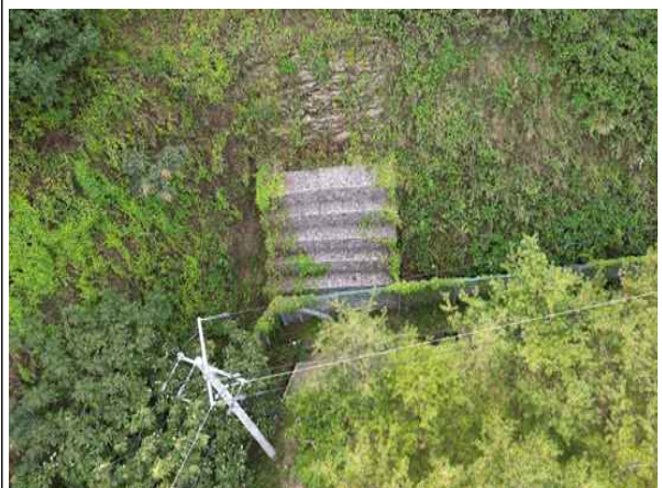
하부, 개미온 전경
