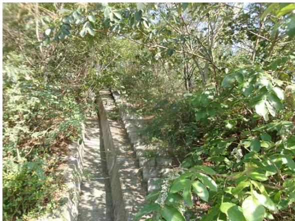
산마루측구, 점검계단 전경
