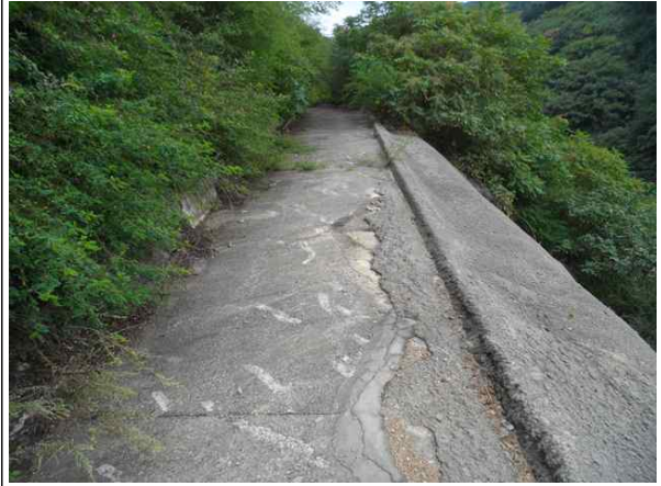
1소단 배수로 전경
