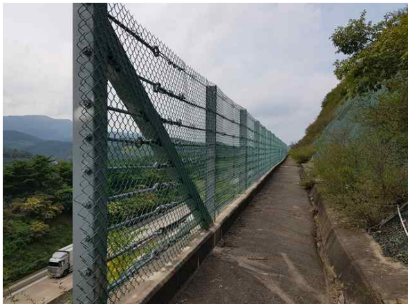
소단배수로 낙석방지울타리 전경
