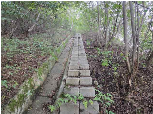
산마루측구, 점점계단 전경
