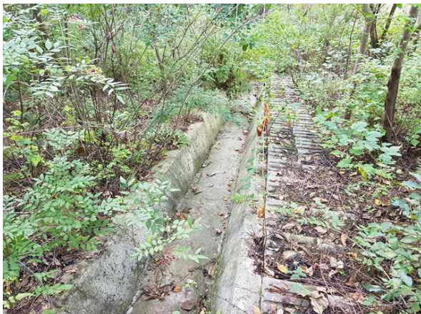
산마루측구, 점검계단 전경
