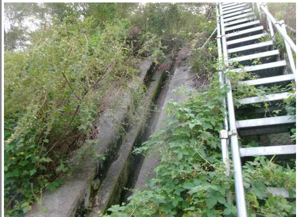
수직도수로, 점점사다리 전경
