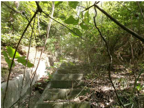
산마루측구, 점점계단 전경
