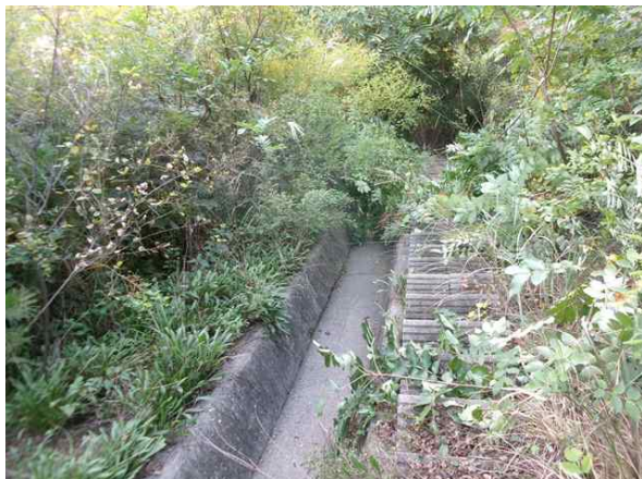
산마루측구, 점검계단 전경
