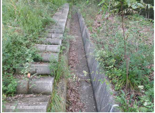
점검계단, 산마루측구 전경
