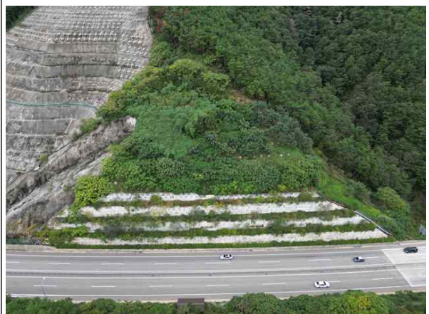
사면내 옹벽(패널식옹벽05) 전경
