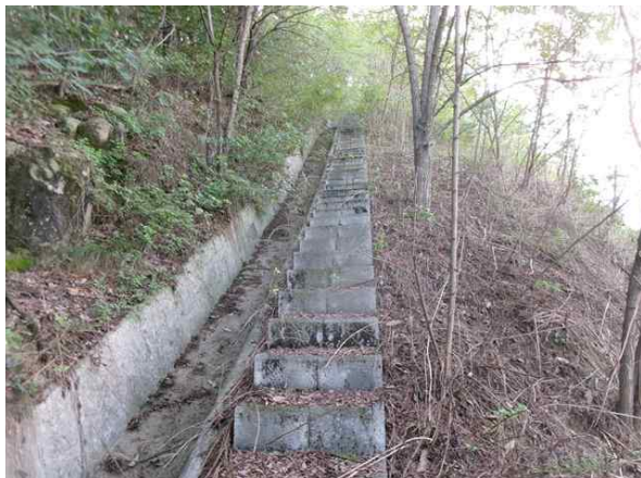
산마루측구, 점점계단 전경
