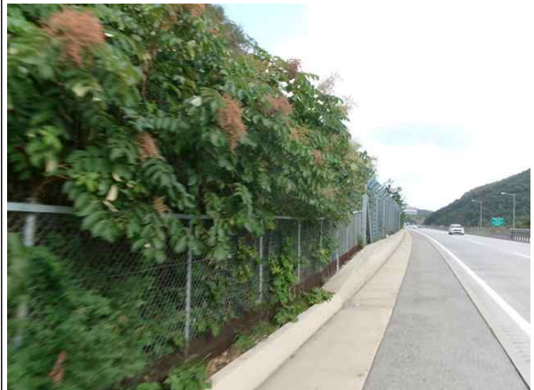
낙석방지울타리, 야생동물유도울타리 전경
