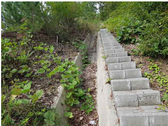
점검계단, 산마루측구 전경
