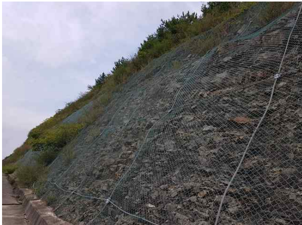
3단 풍화구간, 낙석방지망 전경
