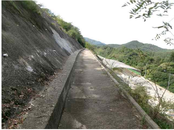
1소단 배수로 전경
