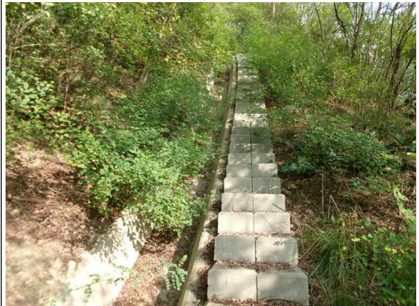
산마루측구, 점검계단 전경
