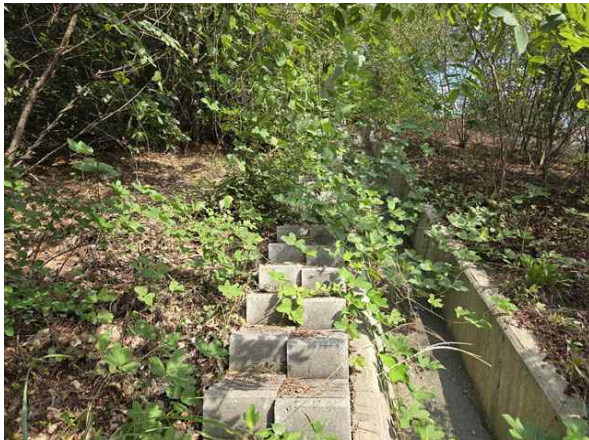
산마루측구, 점검계단 전경
